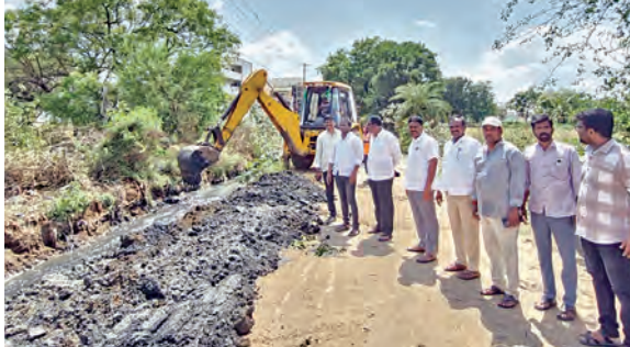
డ్రైనేజీ పనులను పరిశీలిస్తున్న దృశ్యం
